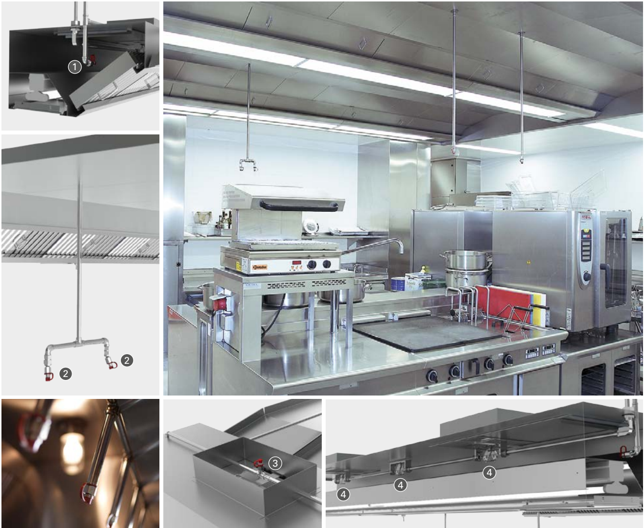
1 - Afzuigplenummondstuk, 2 - Mondstukken voor kooktoestellen, 3 - Kanaalaansluitmondstuk, 4 - Smeltveiligheid afzuigplenum
