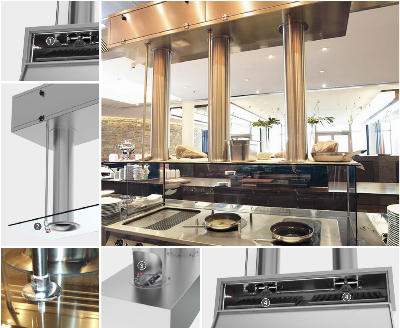
1 - Afzuigplenummondstuk, 2 - Mondstukken voor kooktoestellen, 3 - Kanaalaansluitmondstuk, 4 - Smeltveiligheid afzuigplenum
