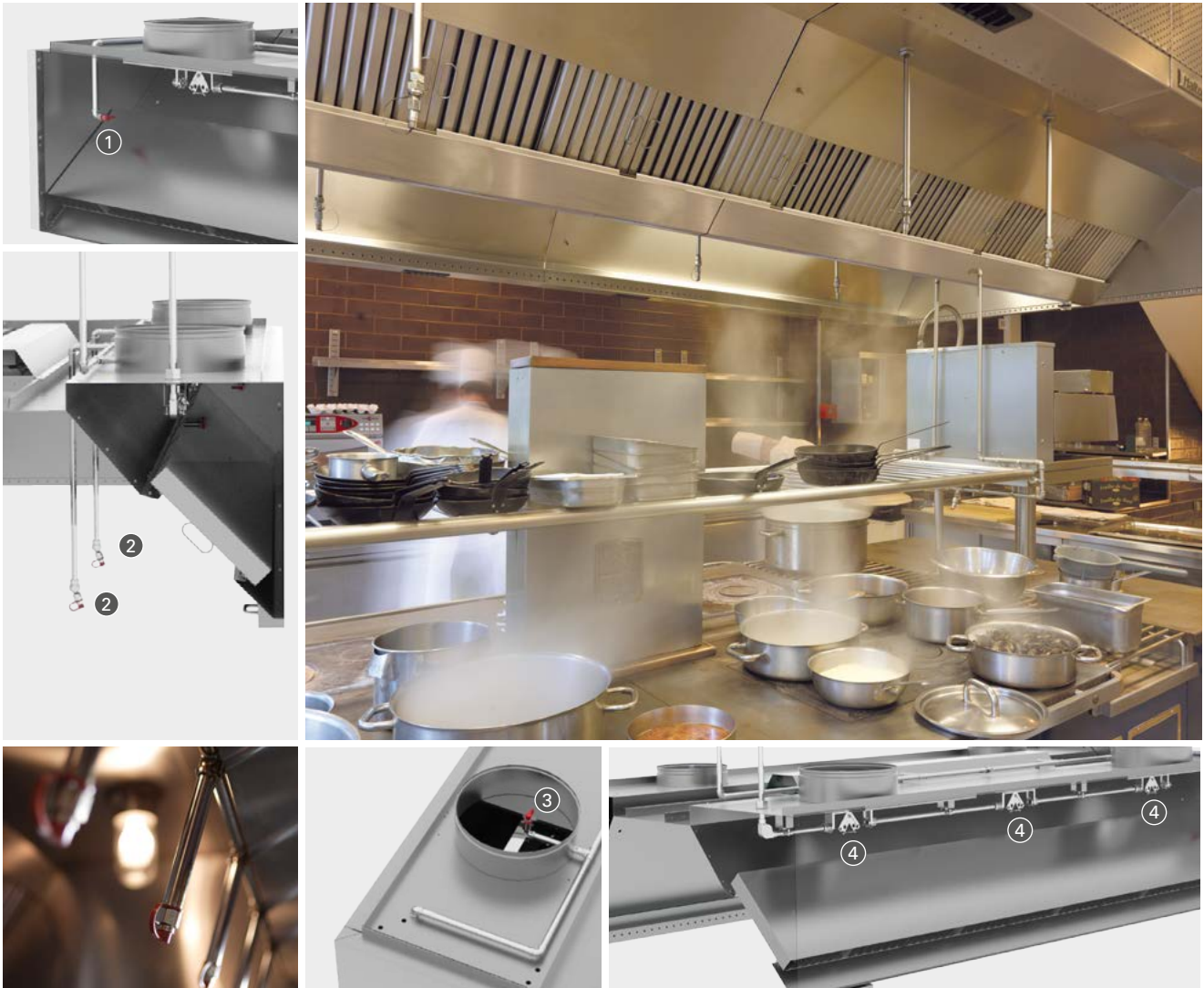
1 - Afzuigplenummondstuk, 2 - Mondstukken voor kooktoestellen, 3 - Kanaalaansluitmondstuk, 4 - Smeltveiligheid afzuigplenum
